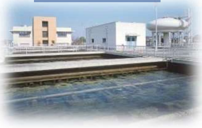
上水処理施設
