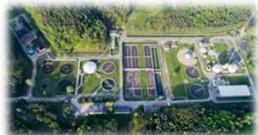
上下水道施設の監視制御
