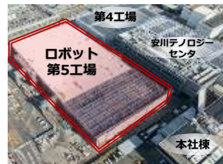
建設中のロボット第5工場
