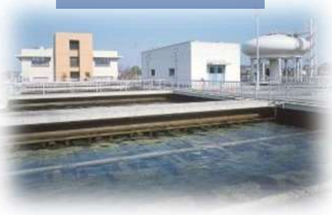
上水処理施設
