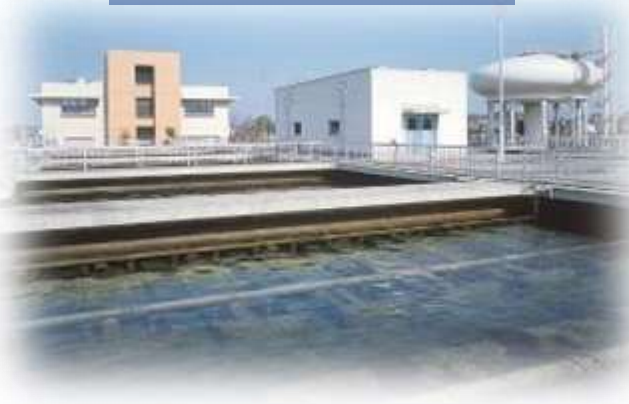
上水処理施設
